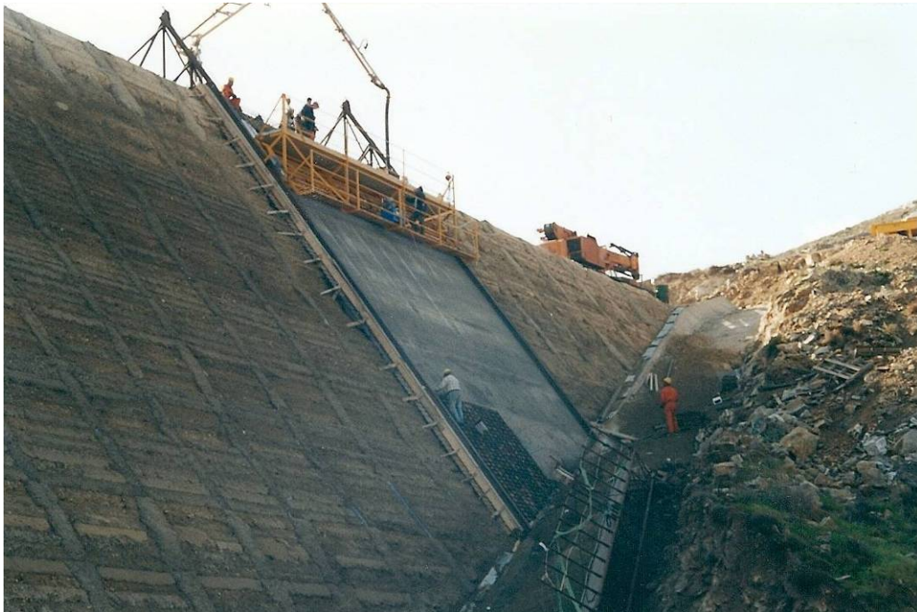
Εικόνα 8: Φράγμα Στενό Σερίφου, κατασκευή μανδύα στεγανότητας (ανάντη πλάκα σκυροδέματος).
