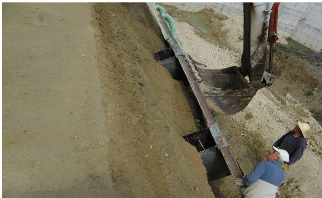
Εικόνα 5: Φράγμα Ληθαίου Τρικάλων, κατασκευή ανάντη πρανούς σκληρού επιχώματος.
