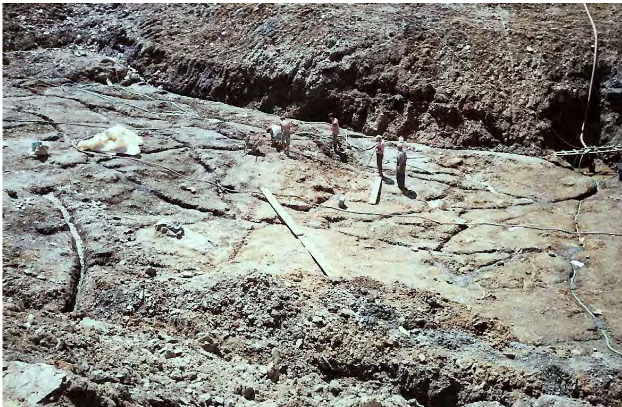
Φωτογραφία 1. Εργασίες Υδρομαστεύσεων Photograph 1. Ground Water Seep Collection and Removal Works.
