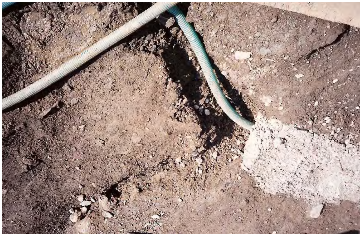
Φωτογραφία 2. Εργασίες Υδρομαστεύσεων (Λεπτομέρεια) Photograph 2. Ground Water Seep Collection and Removal Works (Detail).
